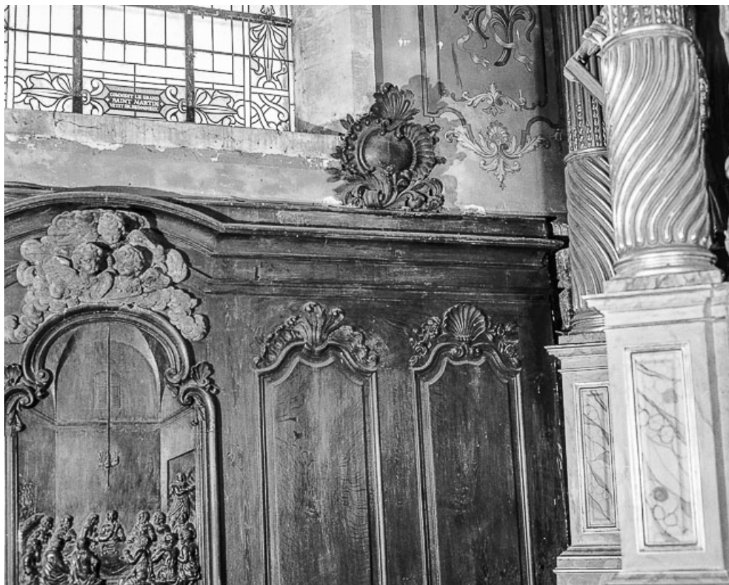
Détail de la partie supérieure des boiseries, côté gauche : 12e et 13e panneaux. 25, Goux-les-Usiers
