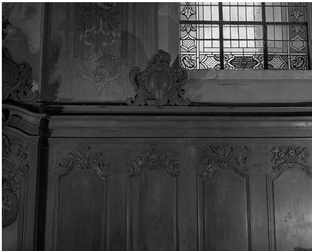
Détail de la partie supérieure des boiseries, côté droit : 5e, 6e et 7e panneaux. 25, Goux-les-Usiers
