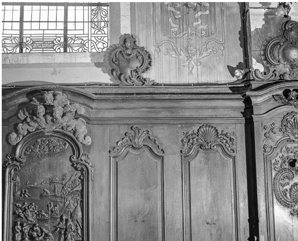
Détail de la partie haute des boiseries, côté droit. 25, Goux-les-Usiers
