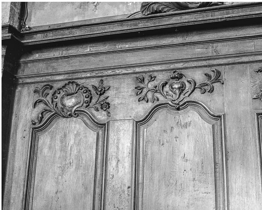
Détail de la partie supérieure des boiseries côté gauche (2e et 3e panneaux). 25, Goux-les-Usiers
