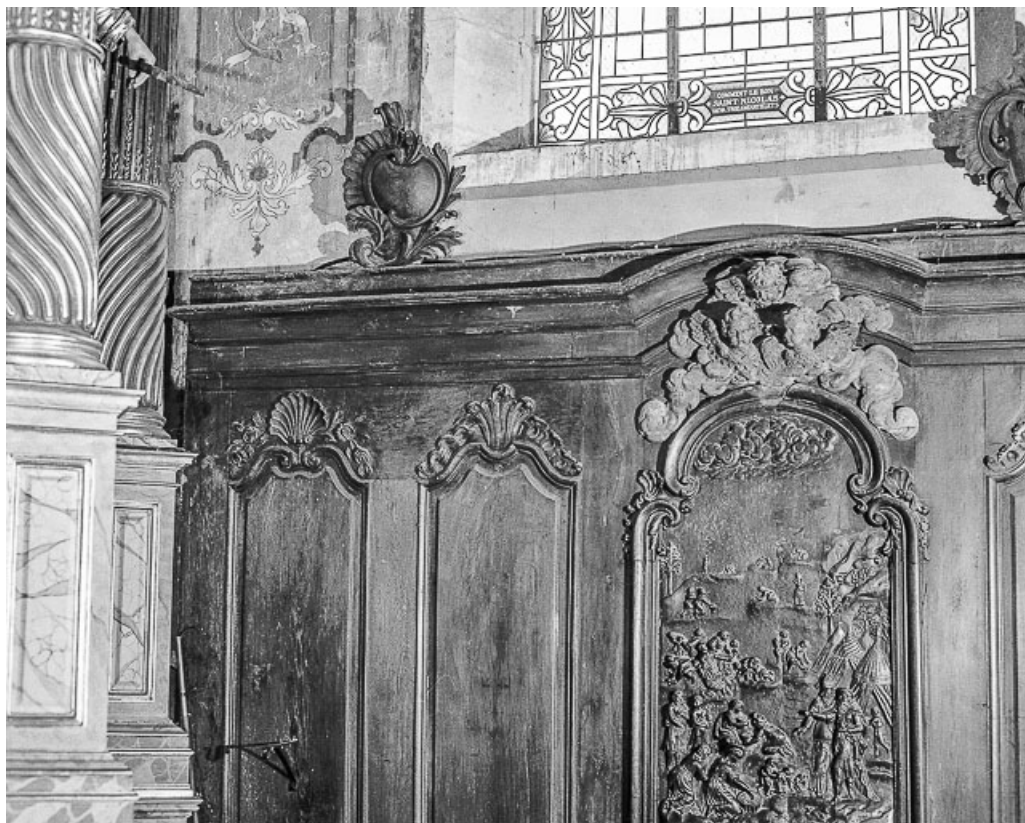
Détail de la partie supérieure des boiseries côté droit : 12e et 13e panneaux. 25, Goux-les-Usiers
