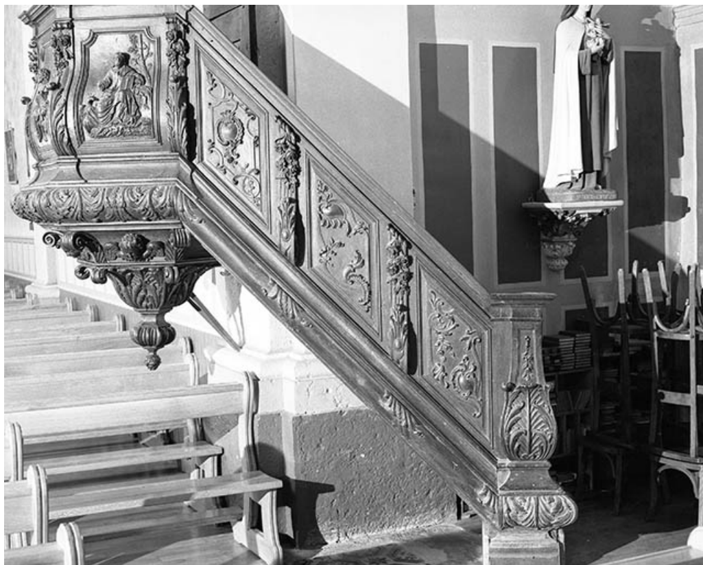
Détail : rampe. 25, Évillers
