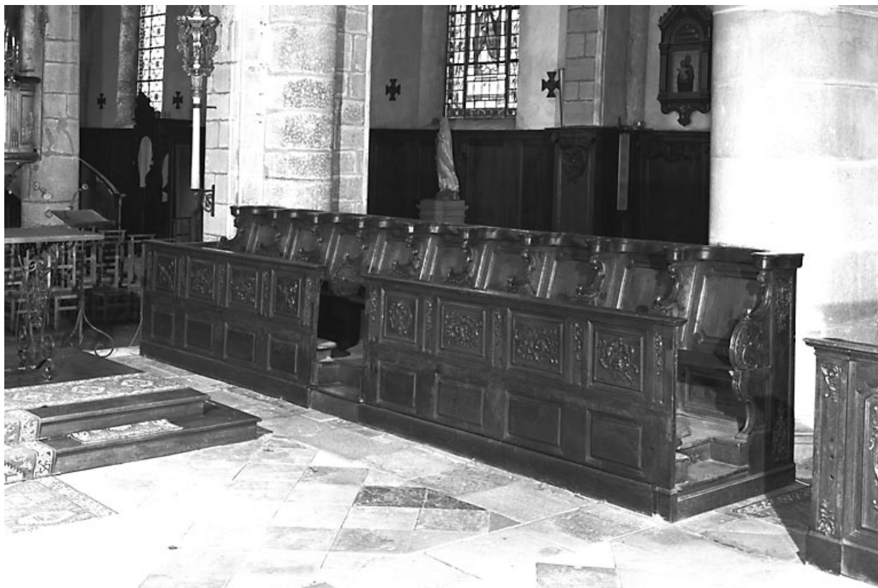
Vue d'ensemble des stalles du côté nord depuis l'entrée de l'avant chœur. 25, Ornans rue Saint-Laurent
