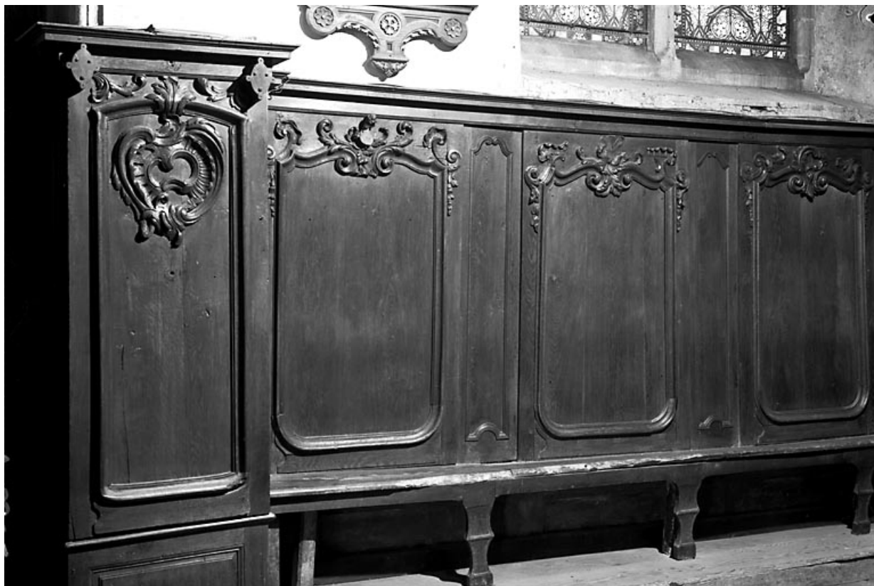
Vue d'ensemble côté nord. 25, Ornans rue Saint-Laurent
