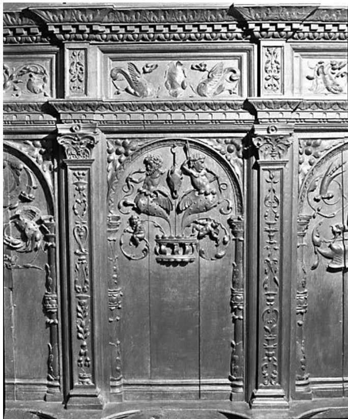
Panneau 2 du 2e groupe des stalles nord. 25, Montbenoît
