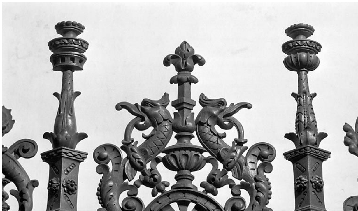
Couronnement n° 13 des stalles nord.
