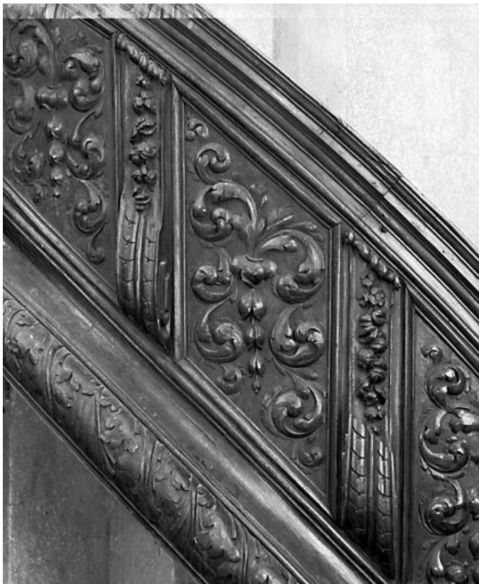
Détail de la rampe. 25, Montbenoît
