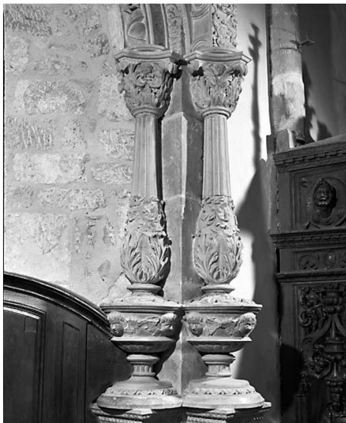
Détail : colonnettes droites.
