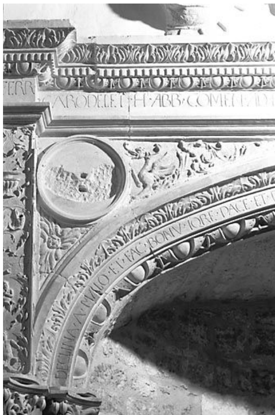
Détail : écoinçon gauche. 25, Montbenoît
