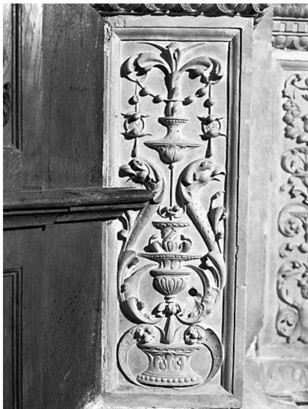
Détail : piédestal de la colonnette interne droite, face gauche. 25, Montbenoît
