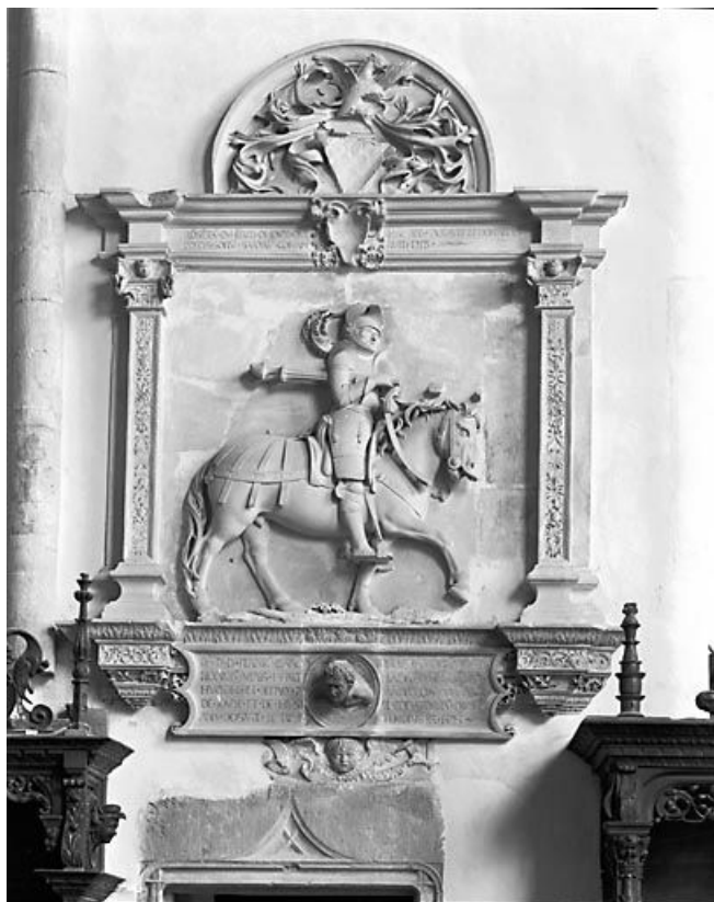
Vue générale. 25, Montbenoît
