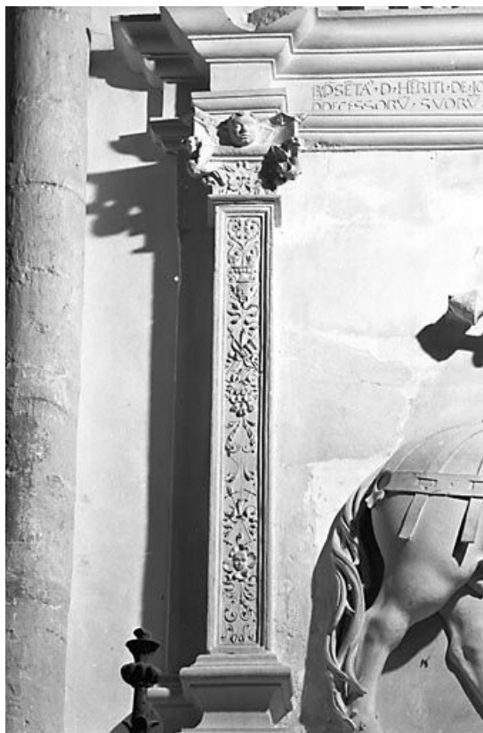
Détail : pilastre gauche. 25, Montbenoît
