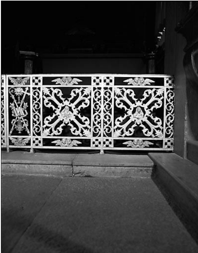
Détail : partie droite. 25, Saint-Gorgon-Main
