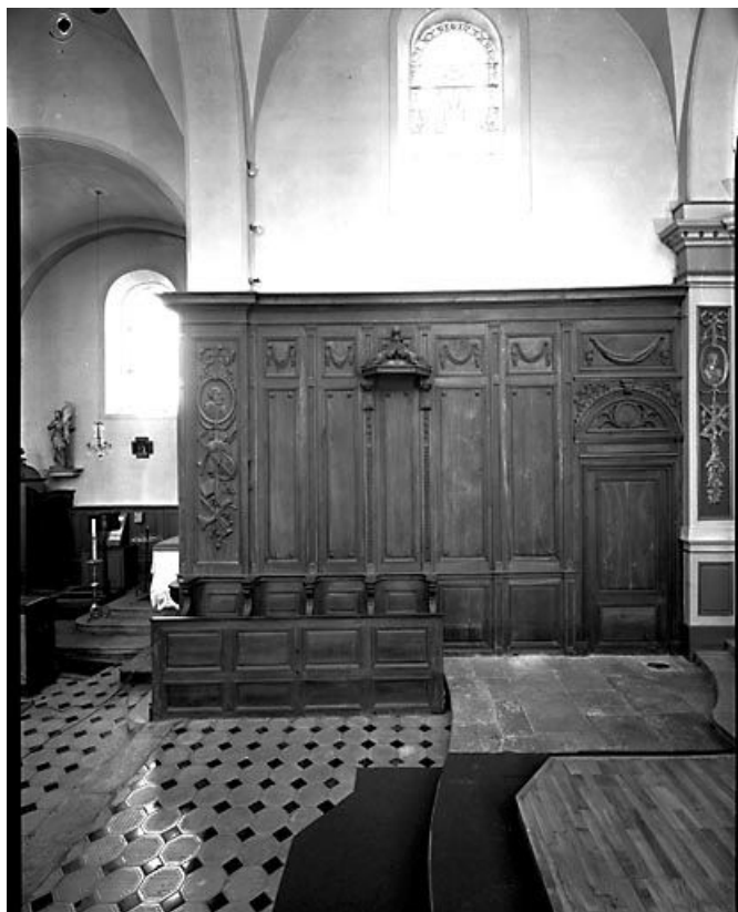
Vue d'ensemble de la partie nord, de face. 25, Aubonne
