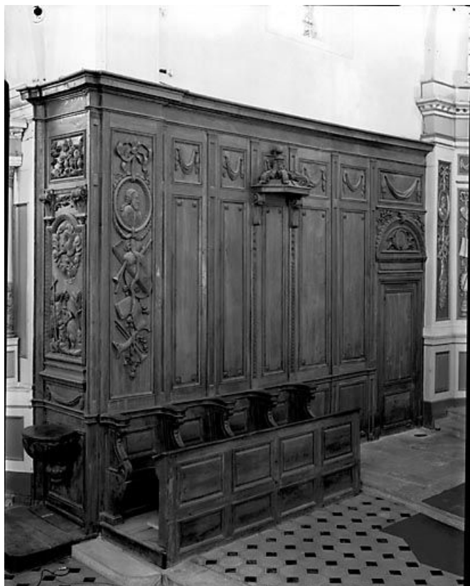
Vue d'ensemble de la partie nord, de trois quarts.
