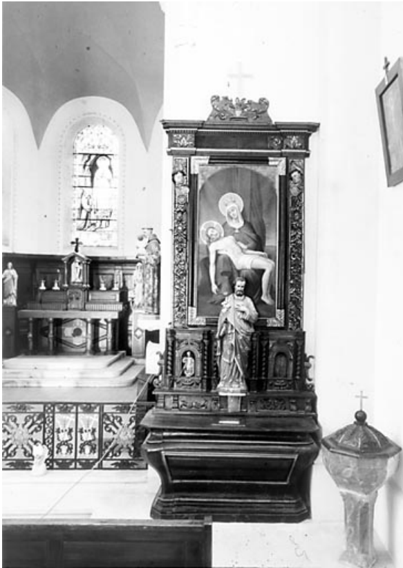
Vue de l'ensemble sud. 25, Bugny
