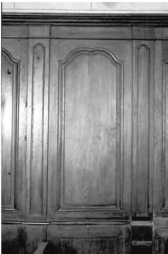
Détail d'un panneau de la nef. 25, Arc-sous-Cicon
