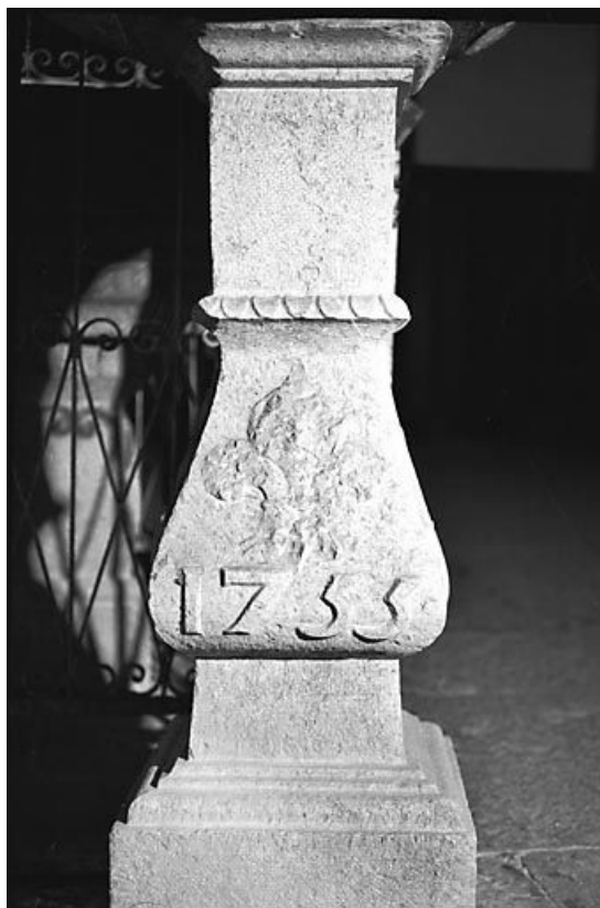
Détail de la date.
