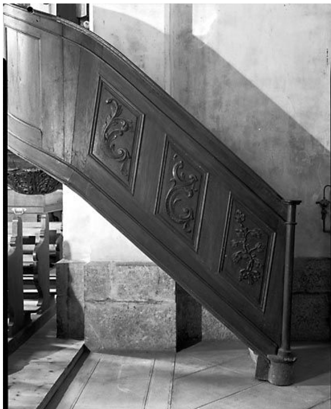
Détail de la rampe.
