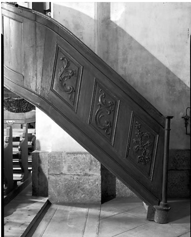
Détail de la rampe.
