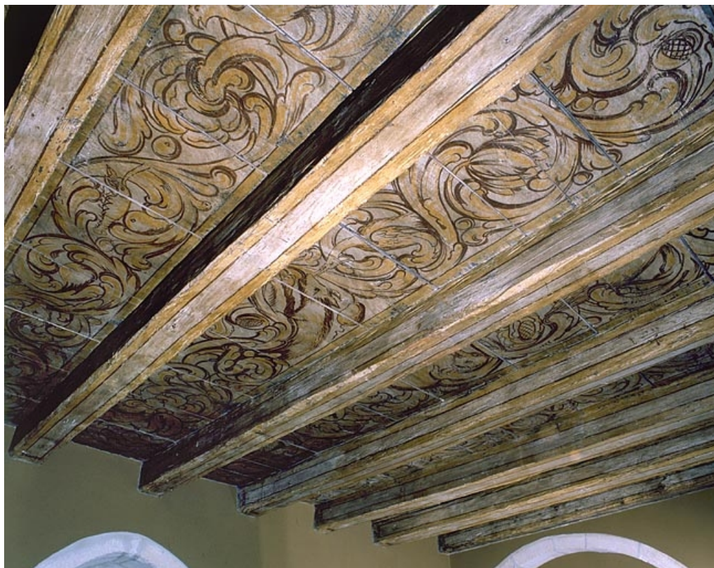
Vue d'ensemble vers l'angle nord-est de la pièce.
