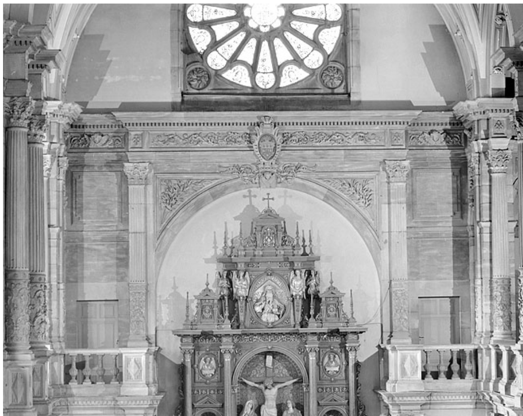
Vue d'ensemble du couronnement, face. 25, Montbéliard rue Saint-Maimboeuf
