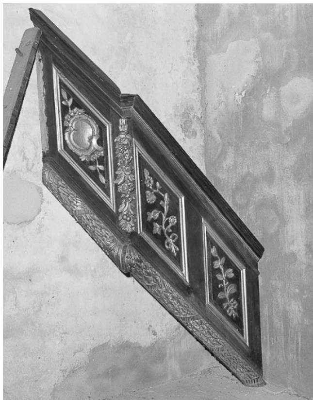
Détail : la rampe.
