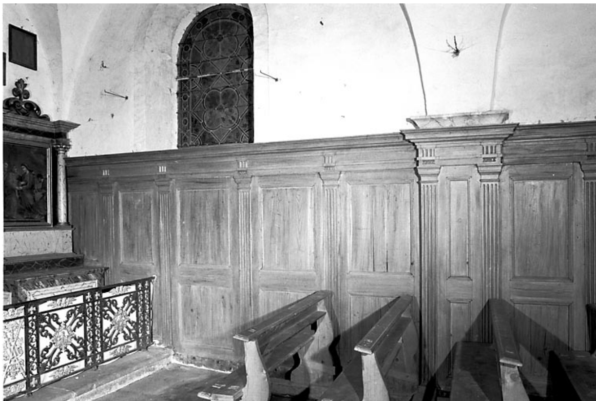
Vue des boiseries de la nef et du choeur.
