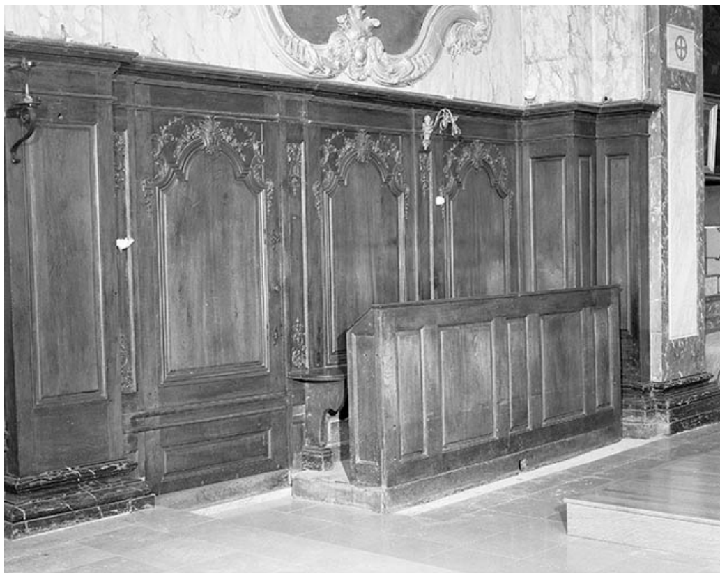
Détail des lambris du mur droit du chœur. 25, Grand'Combe-Châteleu
