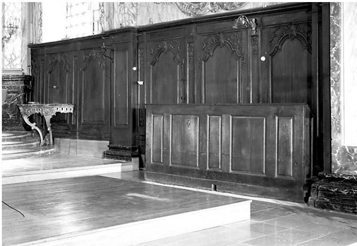
Vue d'ensemble des lambris du mur droit. 25, Grand'Combe-Châteleu
