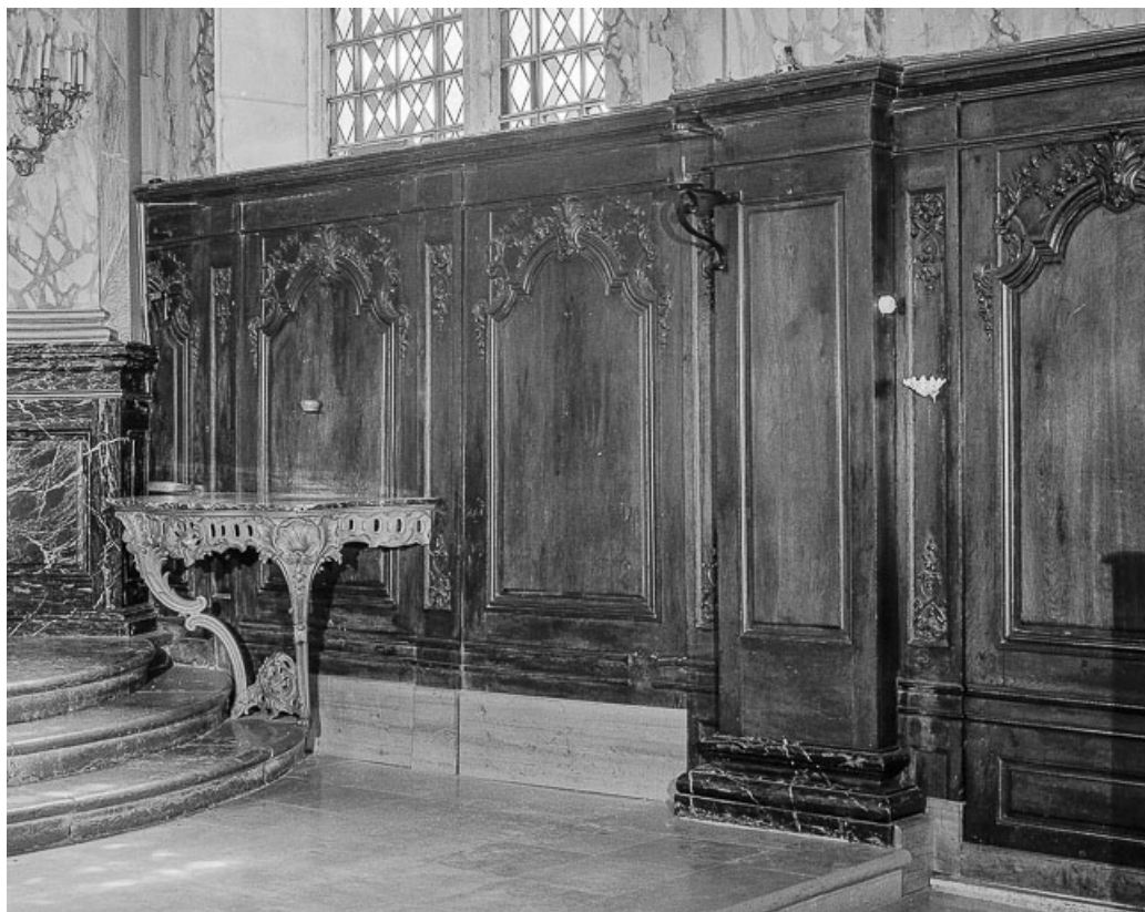
Détail : lambris, mur droit et crédence. 25, Grand'Combe-Châteleu
