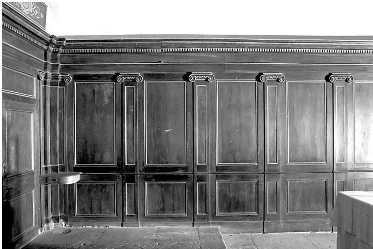
Détail des boiseries du chœur.
