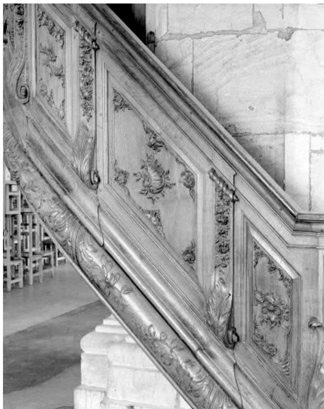
Détail : panneau de la rampe. 25, Morteau
