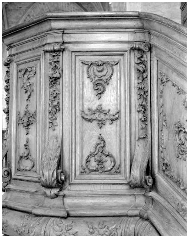
Détail : un petit panneau de la cuve, pan Ouest. 25, Morteau
