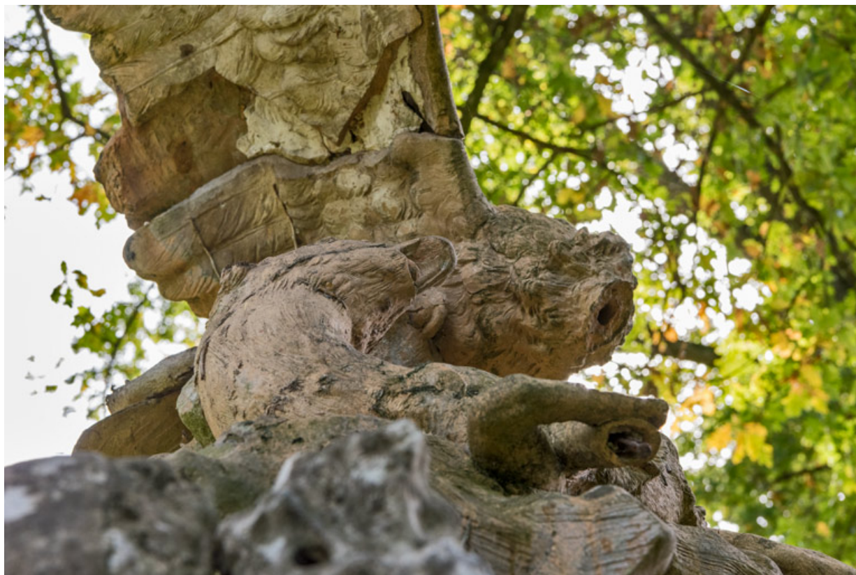
Tête du daim, vue en contre-plongée.
