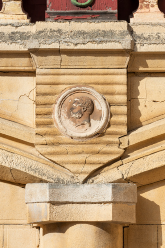
Bas-relief sur l'élévation antérieure de la maison.
