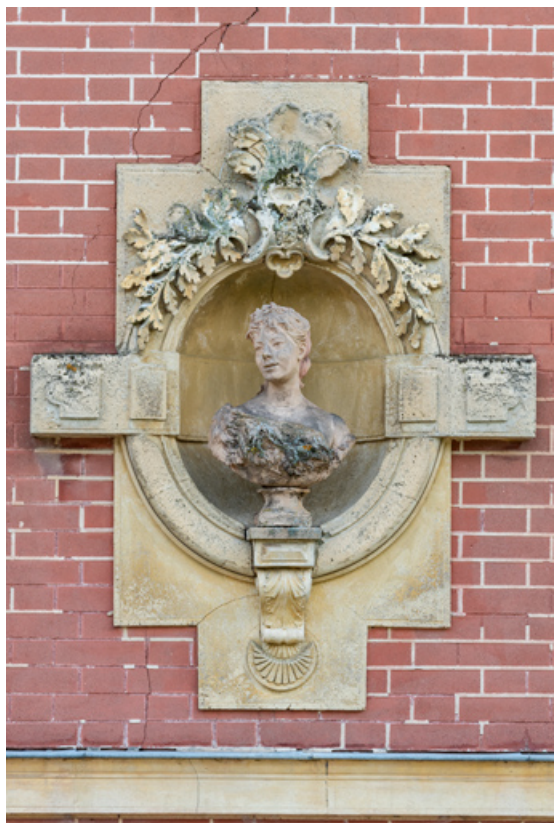
4e buste (à droite sur l'élévation de la maison). 21, Chevigny-en-Valière, 23 rue Mercey
