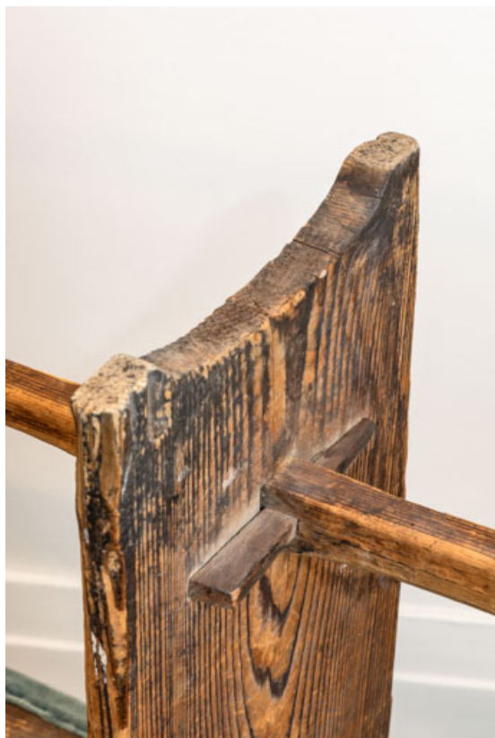
Banc rembourré rustique : détail de l'assemblage de la traverse inférieure. 21, Dijon place du Théâtre
