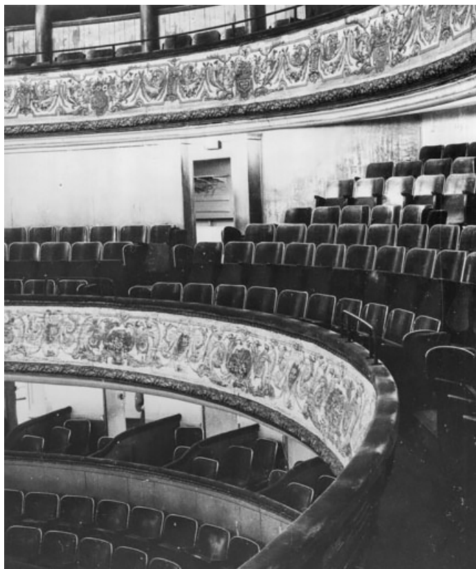
[2e balcon, avant travaux]. S.d. [1969]. 21, Dijon place du Théâtre
