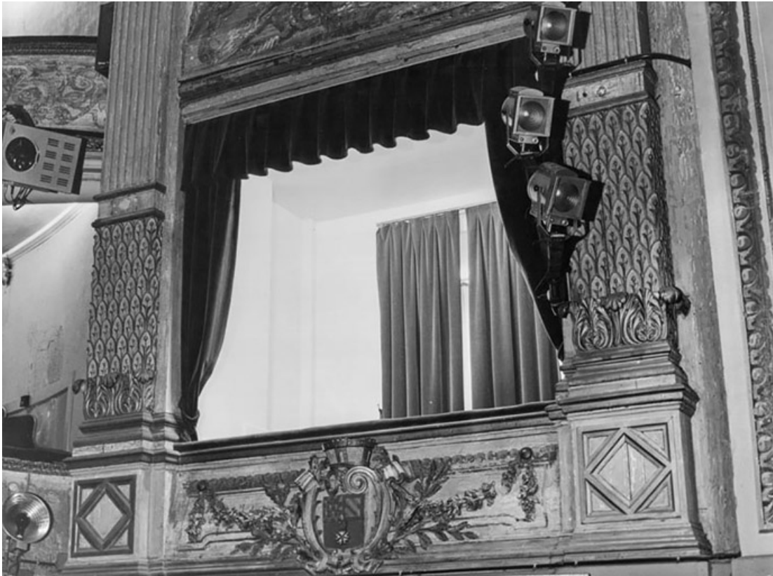
Loge du maire avant tx [travaux]. S.d. [1969]. 21, Dijon place du Théâtre
