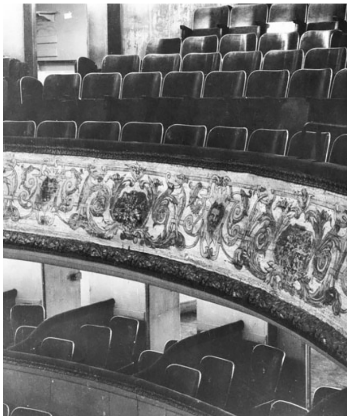
[Loges du 1er balcon et 2e balcon, avant travaux]. S.d. [1969]. 21, Dijon place du Théâtre
