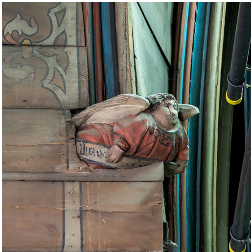
Angle nord-ouest : ange. 21, Dijon, 15 rue Danton
