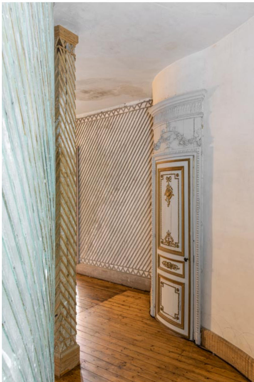
Couloir desservant la salle (à gauche).
