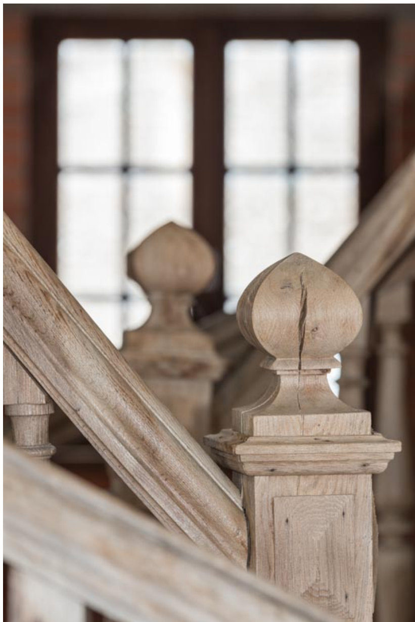
Partie supérieure du départ de rampe : amortissement.
