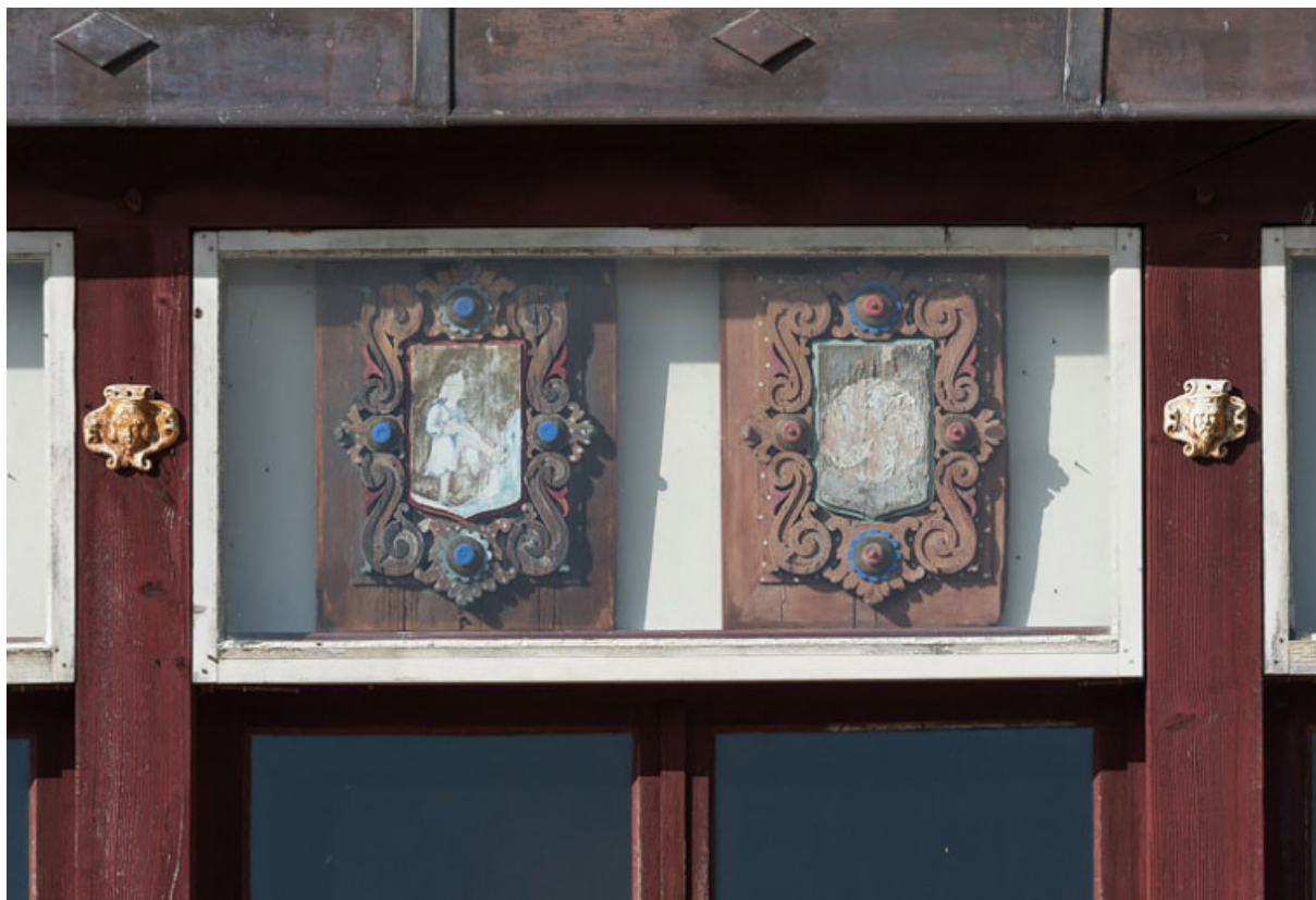
Communs (mur oriental du foyer) : deux armoiries (2e ensemble sur six en partant de la gauche). 21, Chevigny-en-Valière, 23 rue Mercey
