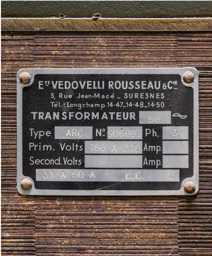
Redresseur Rectarc désaffecté : plaque de constructeur sur l'un des éléments. 21, Beaune, 64 rue de Lorraine
