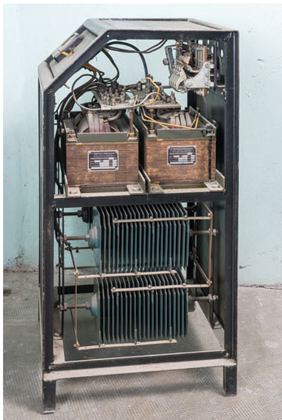
Redresseur Rectarc désaffecté : vue de profil, tôle de protection enlevée. 21, Beaune, 64 rue de Lorraine
