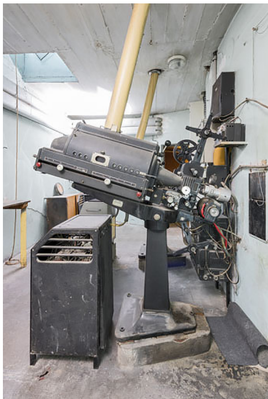
Projecteur côté cour et son redresseur.
