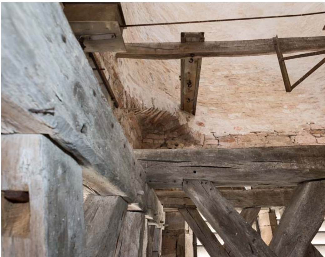
Vue du clocher en tuf et de l'assemblage des poutres.
