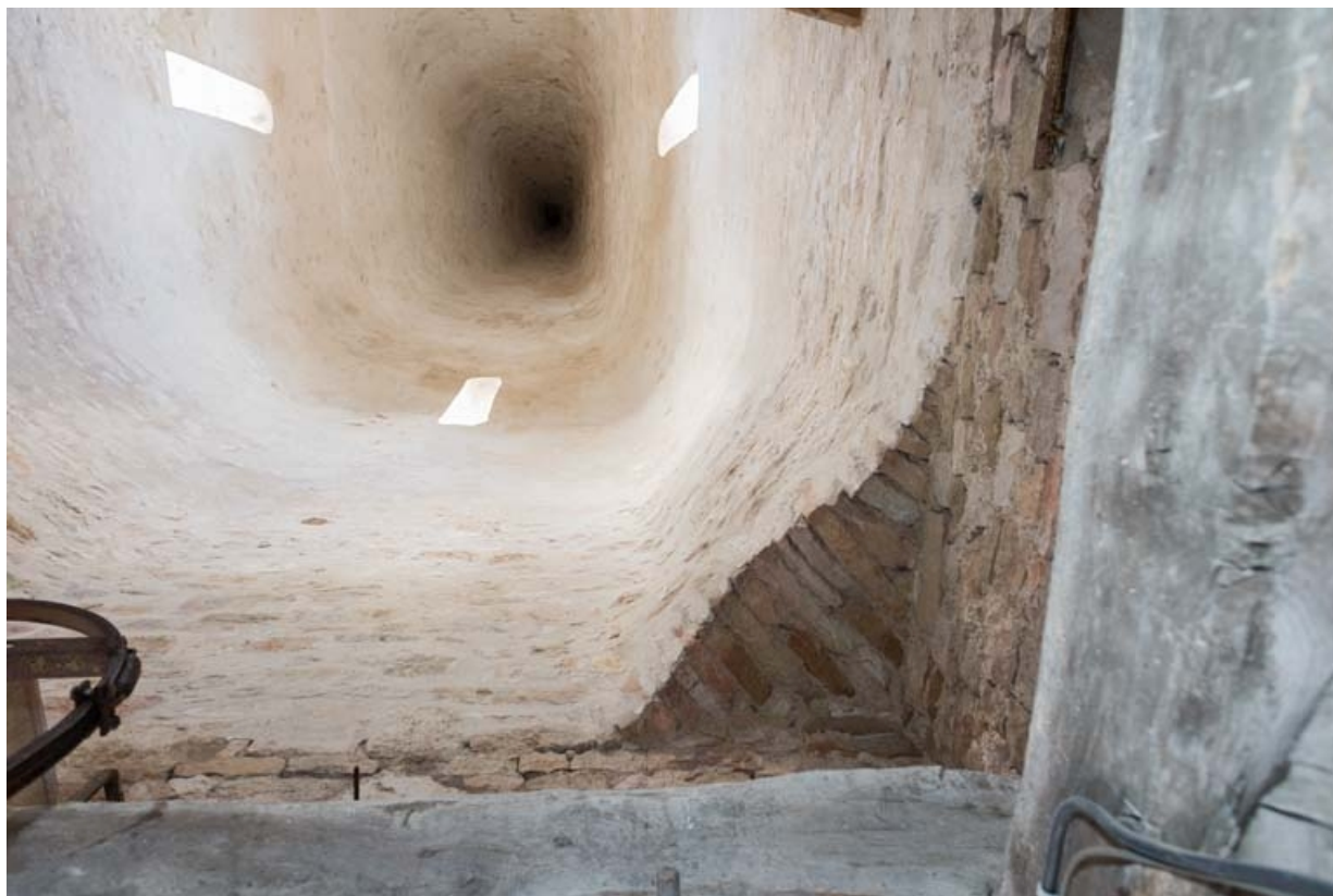
Vue du clocher en tuf depuis le niveau abritant les cloches.
