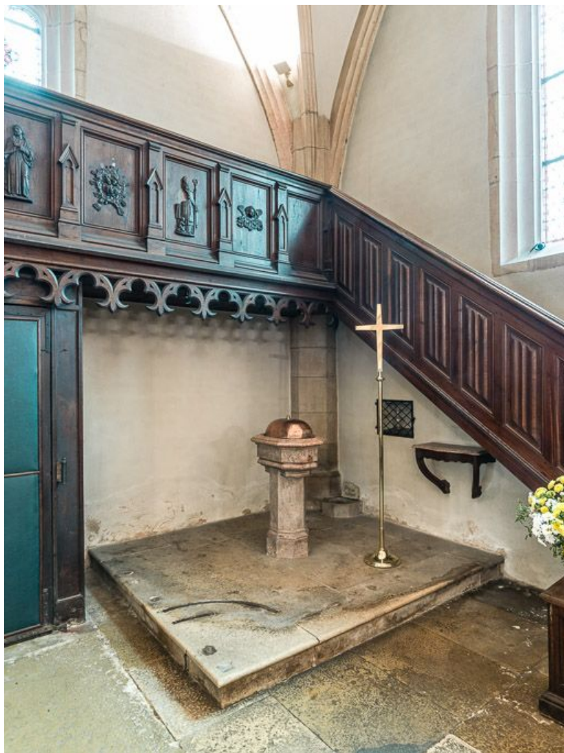
Vue d'ensemble des fonts baptismaux.
