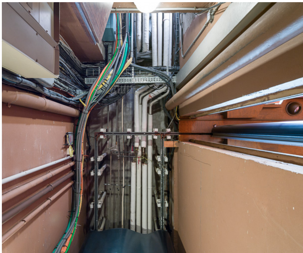
Salle des Assemblées : vue du système de rails pour faire coulisser manuellement la cloison. 21, Dijon
