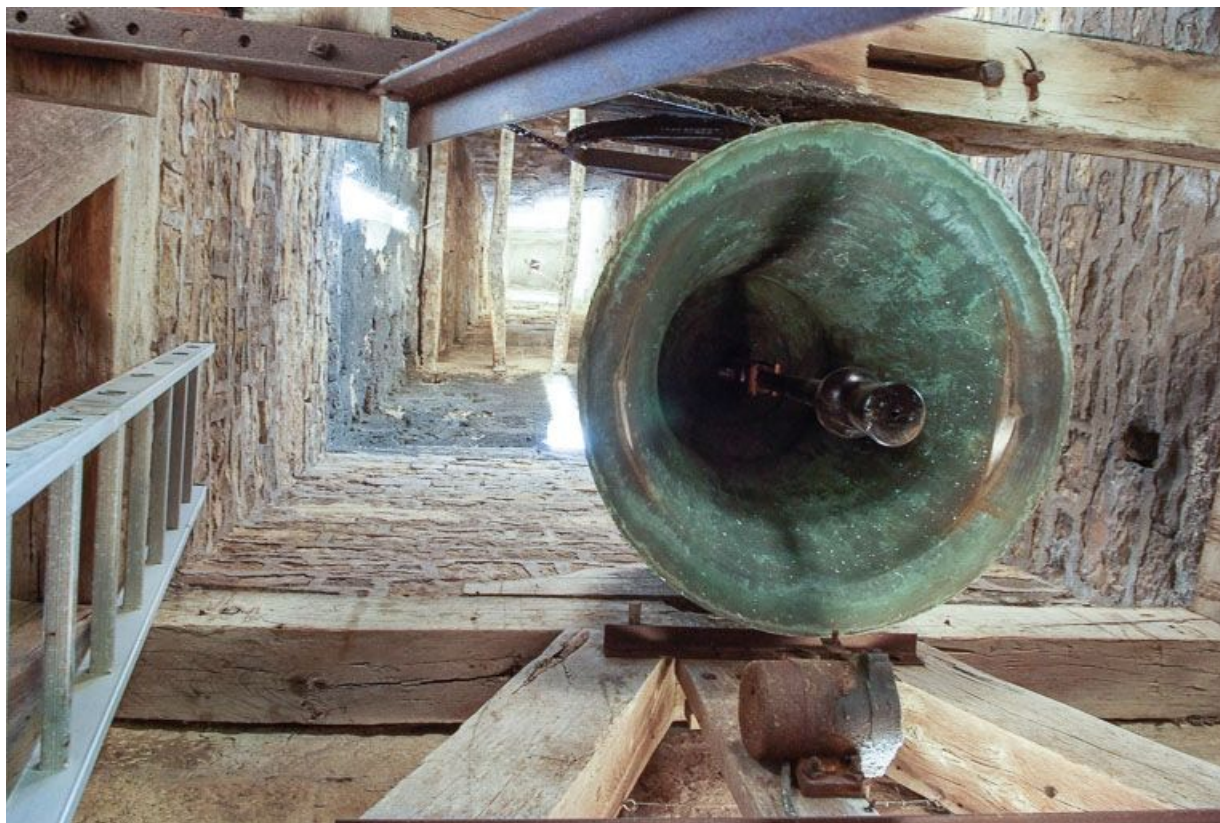
Vue depuis le plancher du beffroi.
