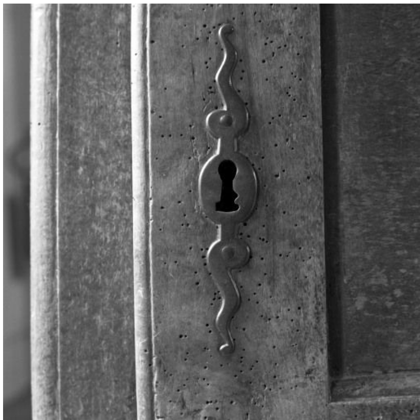
Détail : entrée de serrure.
