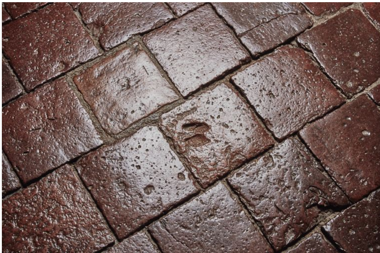
Traces de pattes d'animaux au sol de la chambre de Vienne. 21, Châteauneuf
