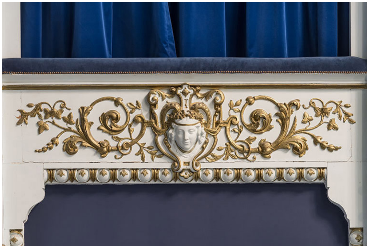
Décor du garde-corps de la loge d'avant-scène côté cour, au 2e balcon. 21, Beaune, 64 rue de Lorraine
