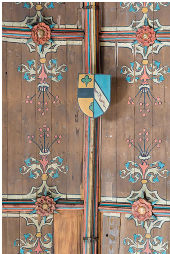
Décor peint de la charpente lambrissée.
