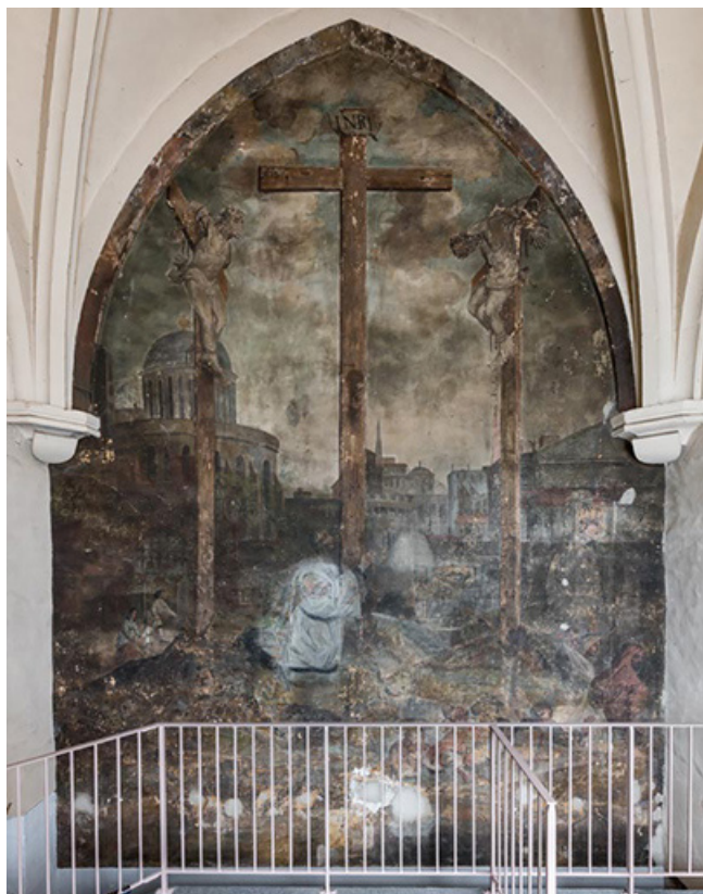
Peinture monumentale dans l'ancienne chapelle du Saint-Sépulcre (rez-de-chaussée de la tour sud). 21, Dijon, 15 rue Danton
