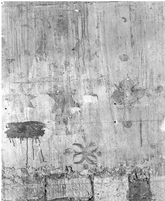
Choeur, mur sud : traces de décor.
