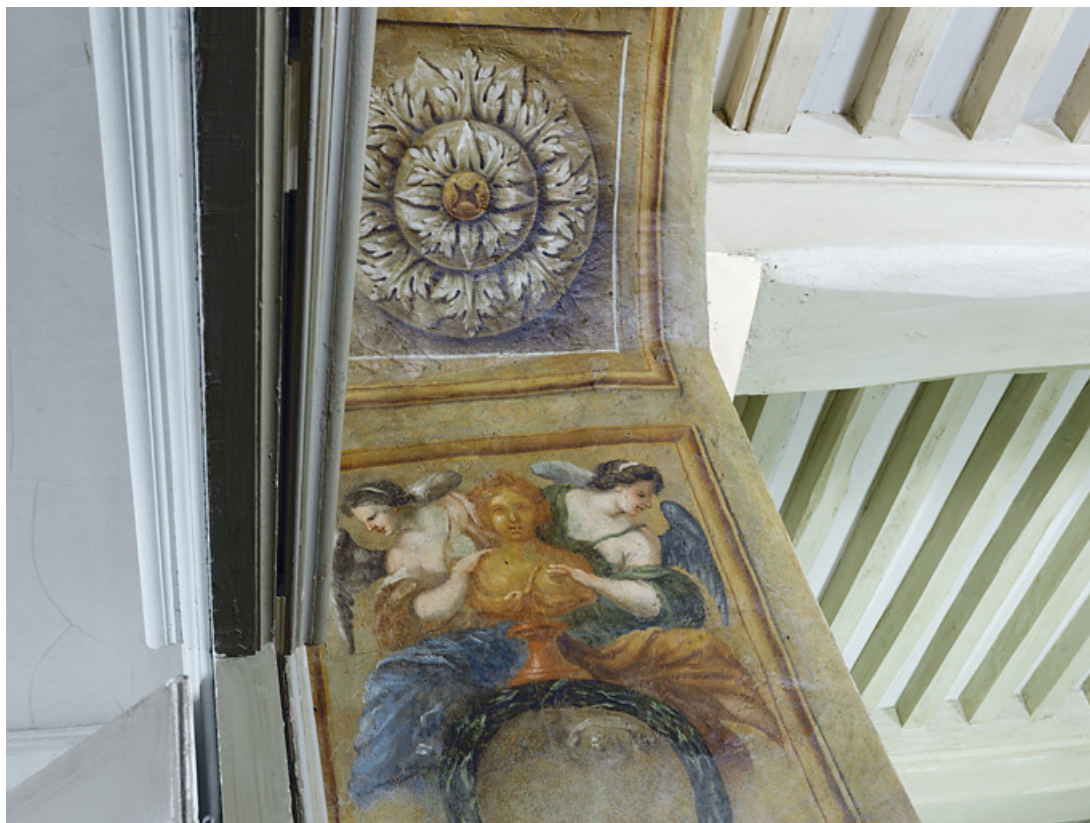
Peinture de l'embrasure de la porte : détail. 21, Châteauneuf château fort
