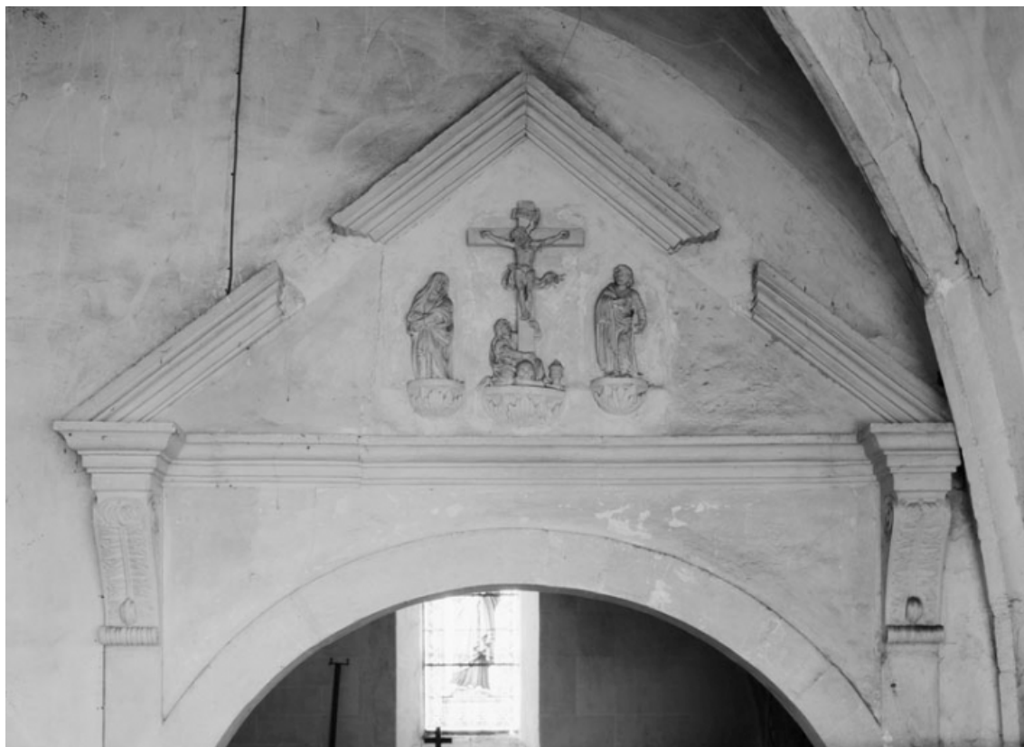
Couronnement de l'arcade d'entrée de la chapelle.
