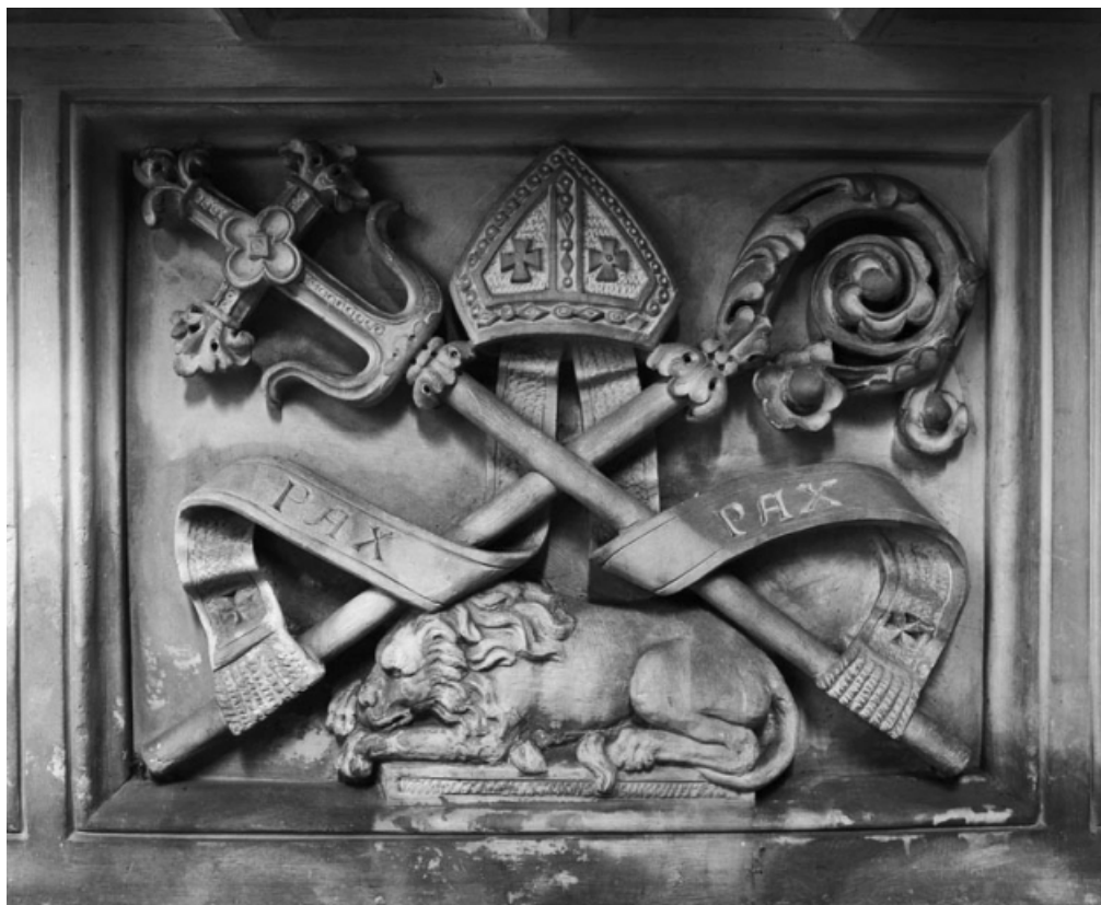
Vue d'un détail de l'autel latéral droit. 21, Corpeau
