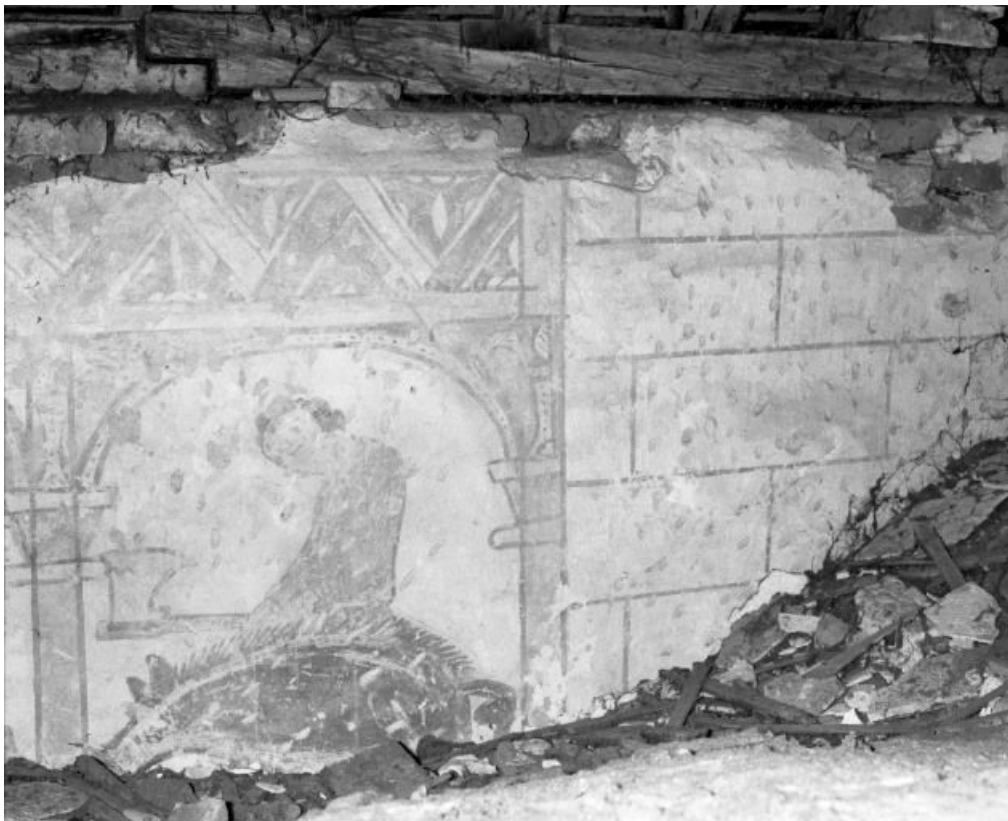
Comble de la nef, mur droit : décembre 21, Pagny-la-Ville
