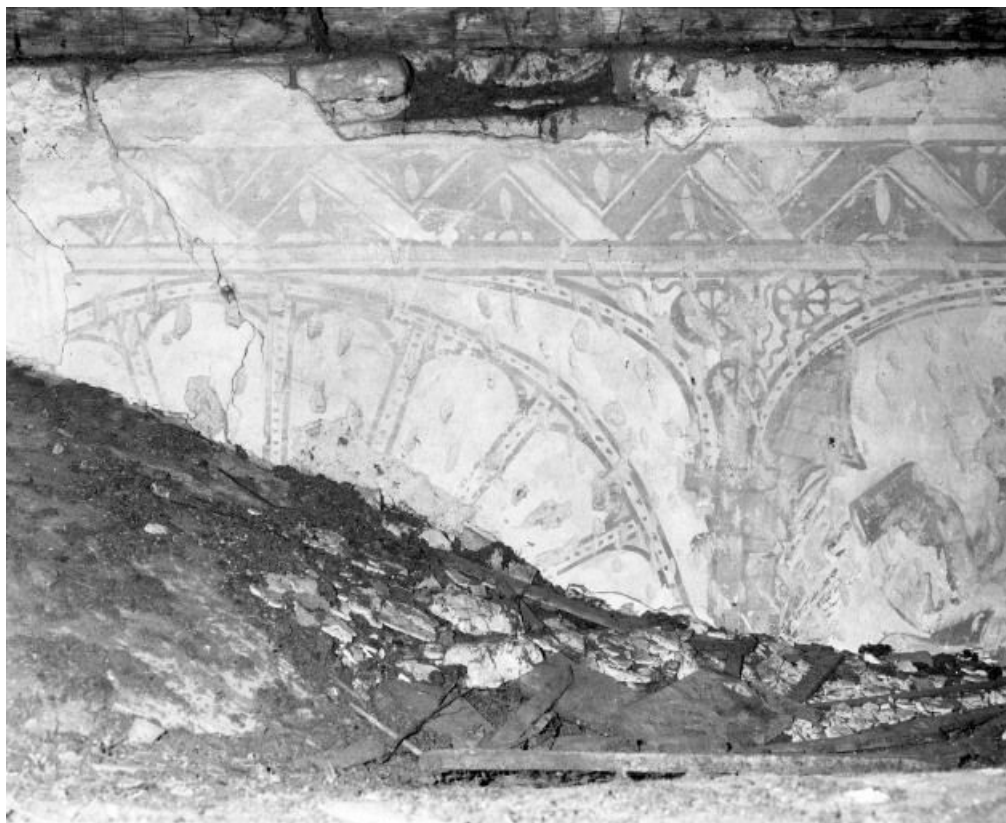
Comble de la nef, mur droit, 4e-5e travées 21, Pagny-la-Ville
