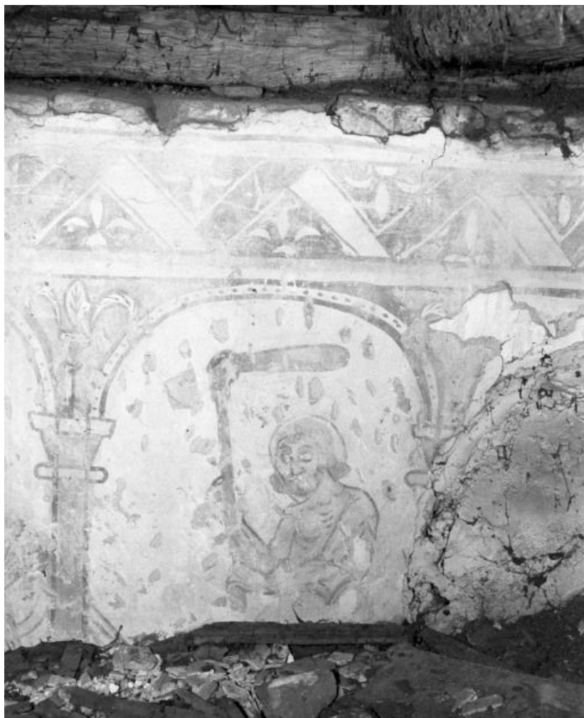
Comble de la nef, mur droit, 3e-4e travées : août 21, Pagny-la-Ville
