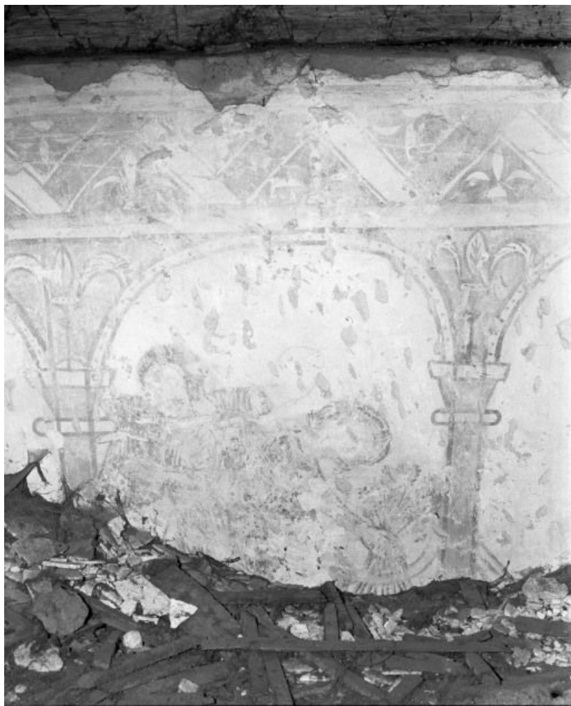
Comble de la nef, mur droit, 3e-4e travées : juillet 21, Pagny-la-Ville
