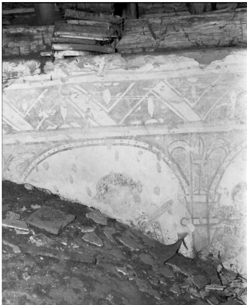
Comble de la nef, mur droit, 3e-4e travées : juin 21, Pagny-la-Ville
