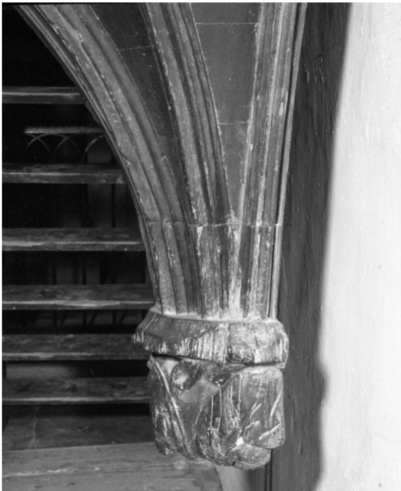
Détail de la cuve:culot
