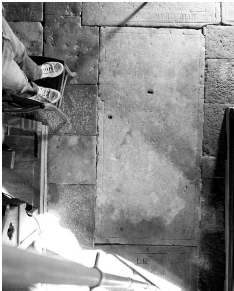
Vue générale 21, Corberon
