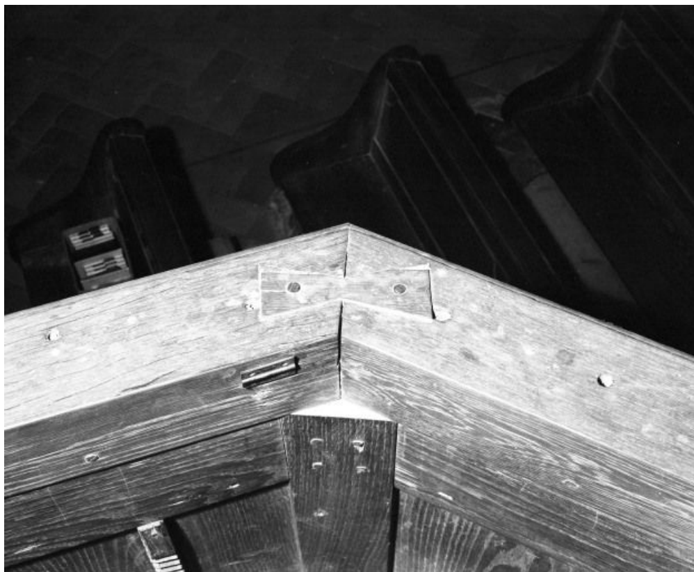
Détail de l'assemblage de l'appui rapporté de la cuve 21, Chivres Grande Rue
