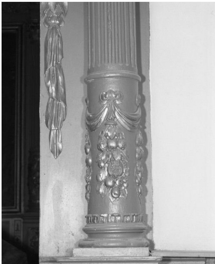
Retable droit, détail d'une colonne
