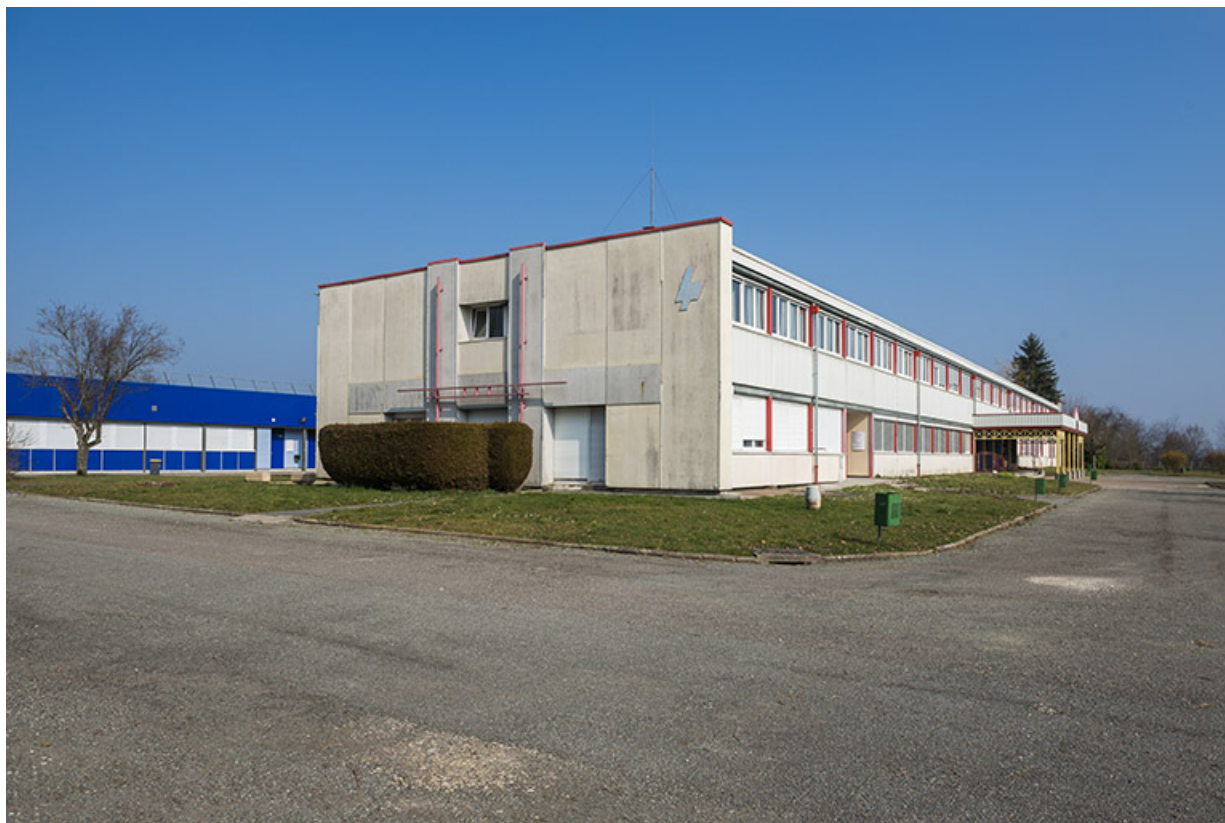
Pignon ouest et façade sud de l'externat nord.
