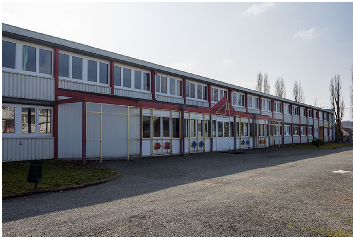
Détail de la façade antérieure nord sur cour de l'externat sud.
