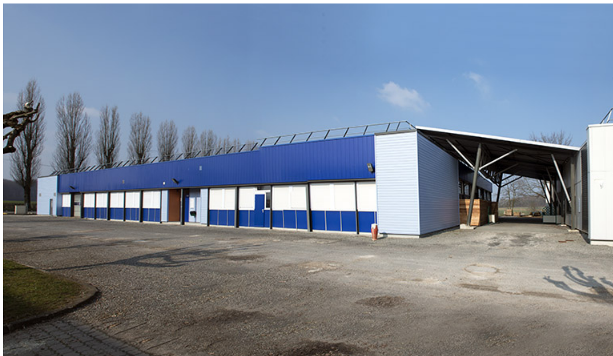
Façade sud et angle sud-est de l'atelier ouest consacré au bois.
