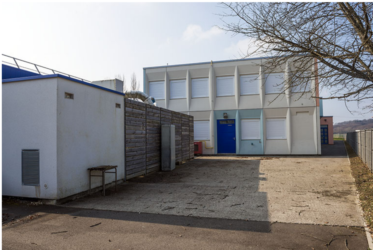
Façade nord-est de l'atelier ouest de peinture et productique.
