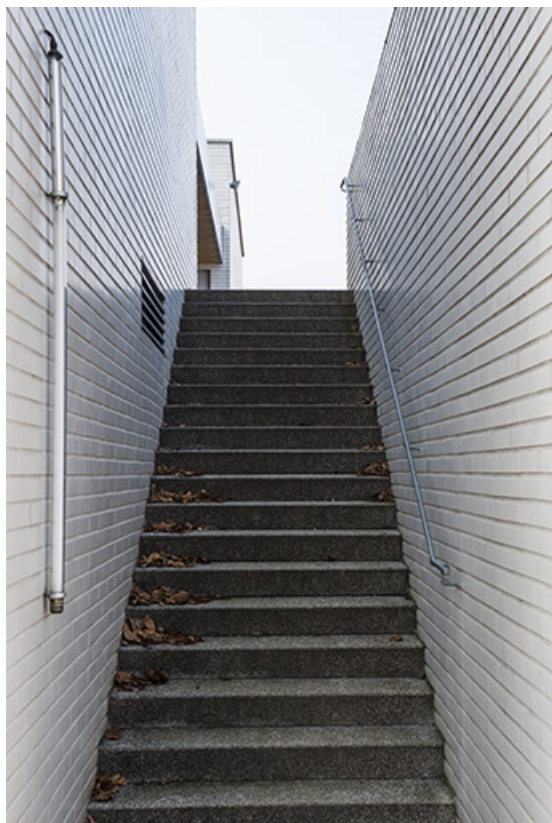
Détail d'escalier le long de la façade orientale de la restauration. 90, Delle, 18 rue de Verdun
