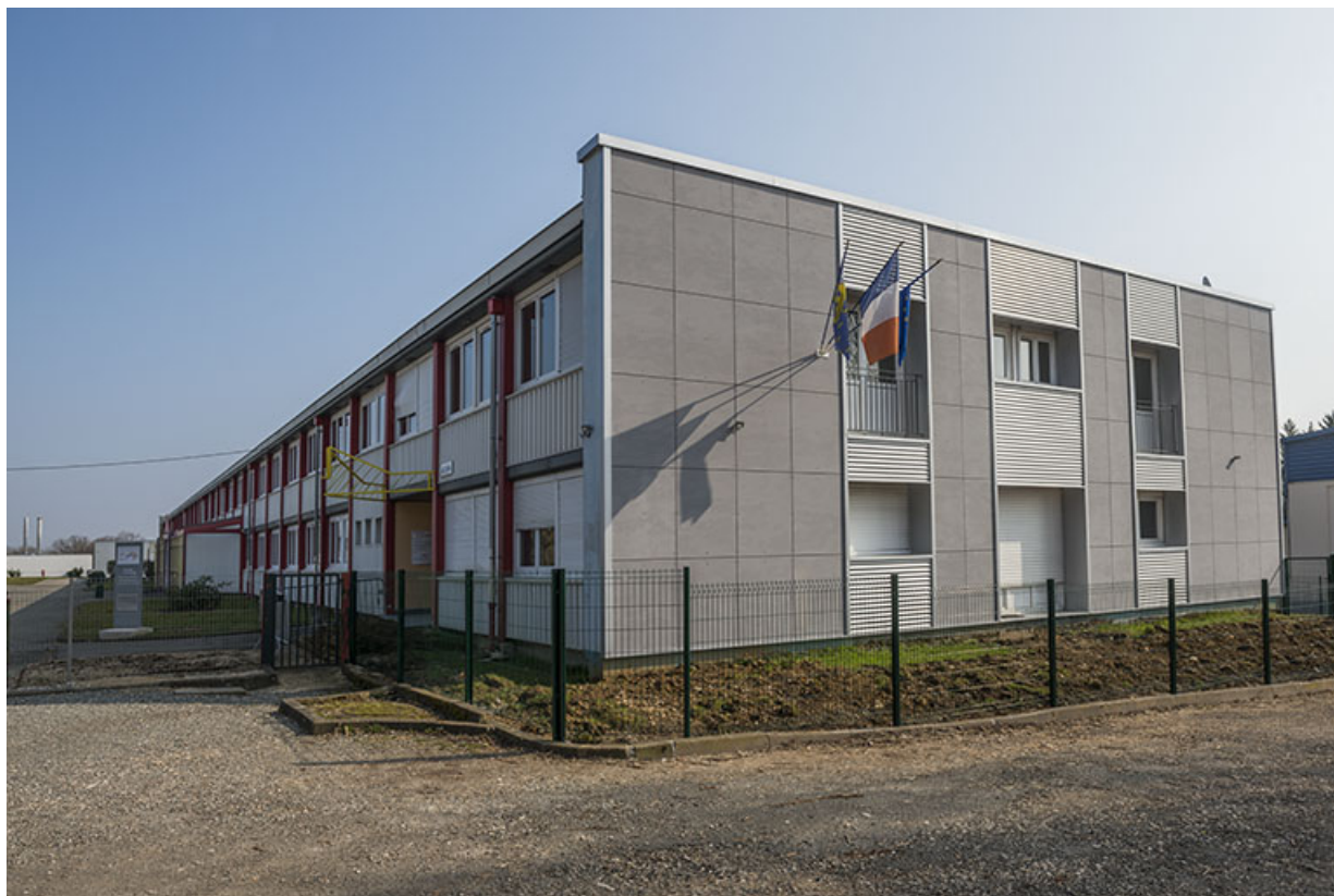
Pignon ouest et façade antérieure nord sur cour de l'externat sud. 90, Delle, 18 rue de Verdun
