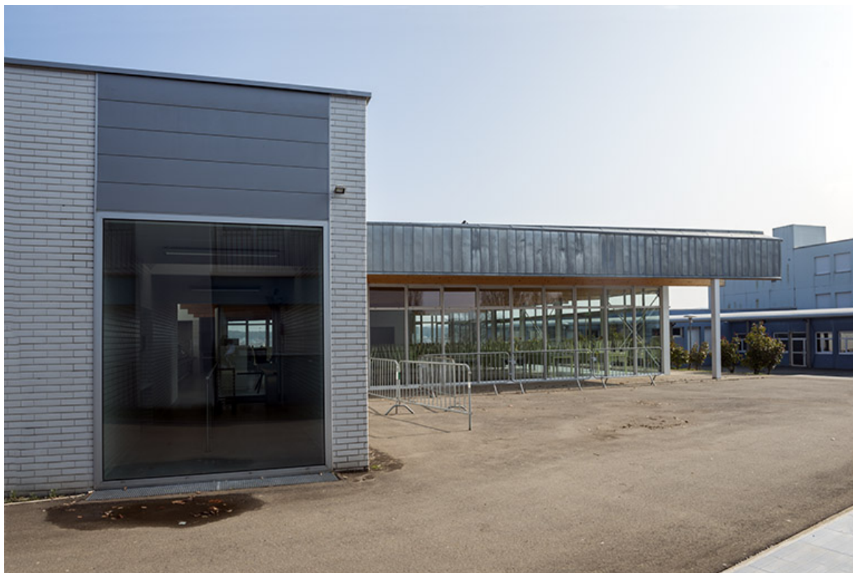
Détail de la façade ouest d'entrée de la cantine.
