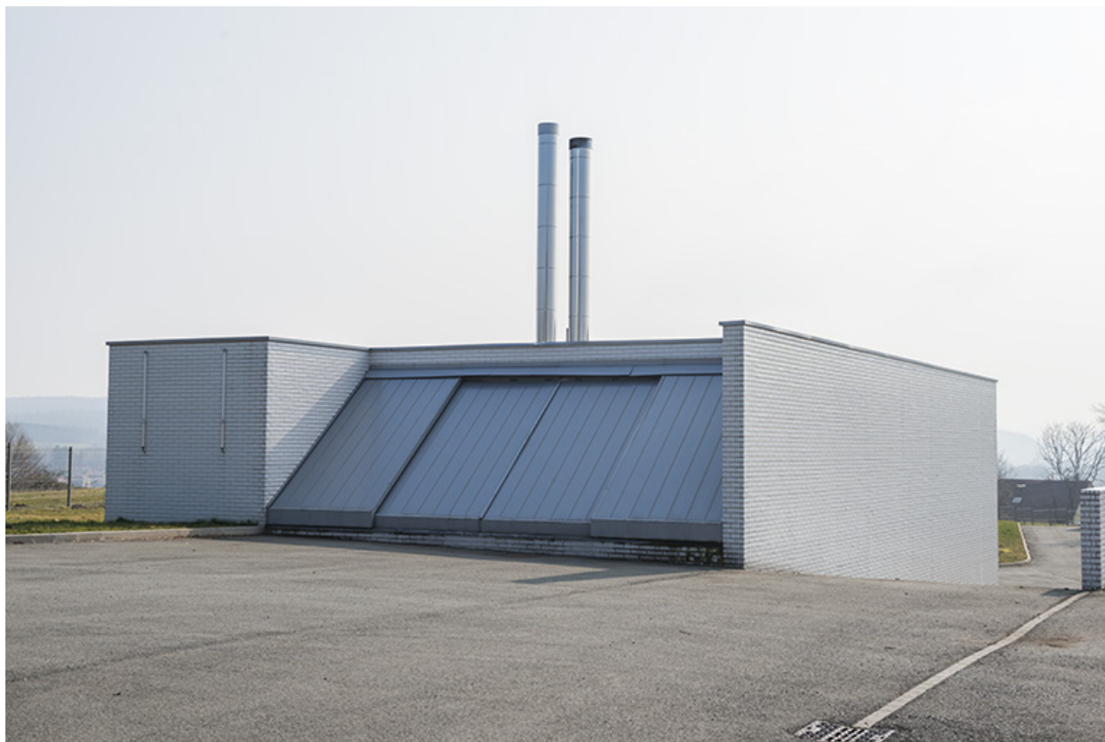
Façade de chargement du combustible et angle nord-ouest de la chaufferie.
