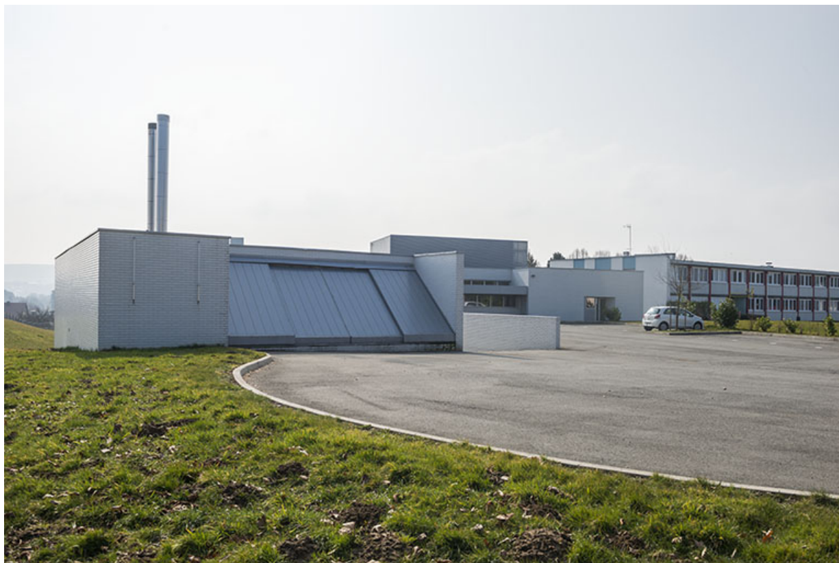
Angle nord-est de la chaufferie, restauration et externat.
