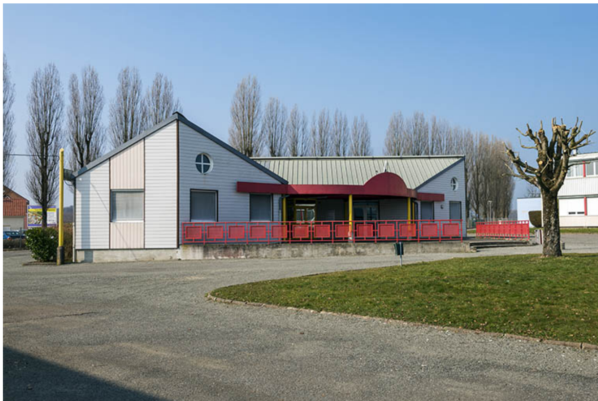
Façade ouest d'entrée du bâtiment de la vie scolaire.
