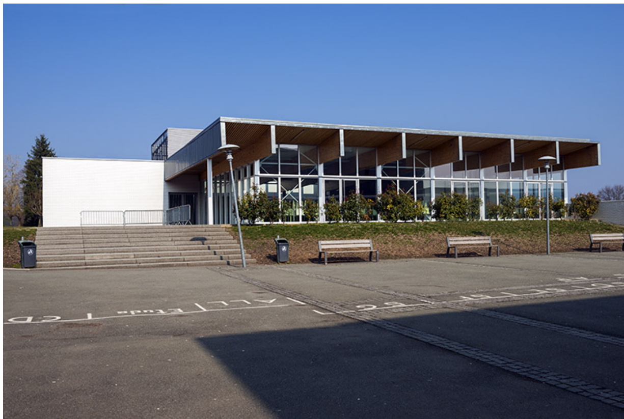
Façade sud de la cantine.
