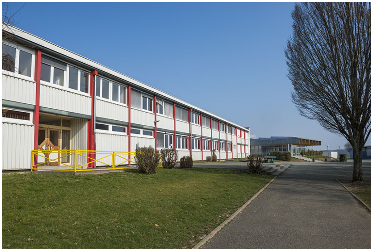
Façade sud de l'externat sud.
